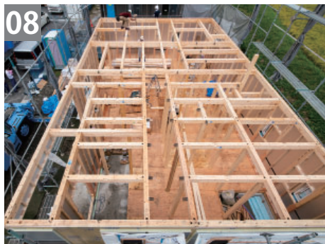
柱と梁の施工完了
