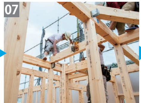
金物による柱と梁の施工
