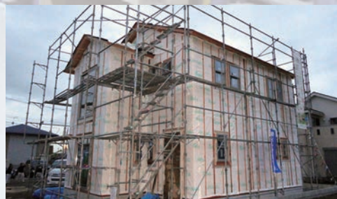
木造大型パネルの設置・上棟
