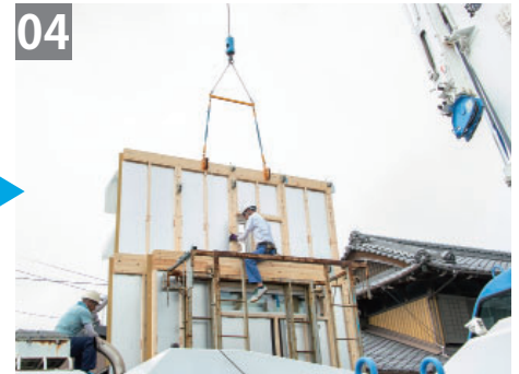
クレーンによるパネル吊り上げ
