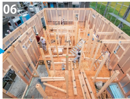
1階壁面の施工完了
