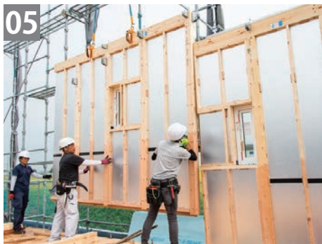
1階壁面の施工
