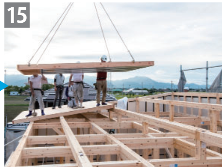
屋根パネルの施工
