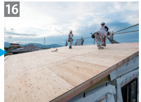
屋根施工完了
