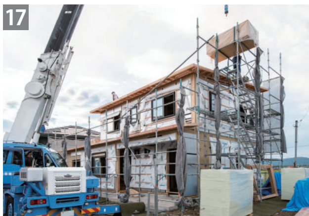
妻壁パネルの施工
