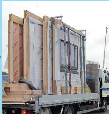
完成した木造大型パネルの 搬出・納入
