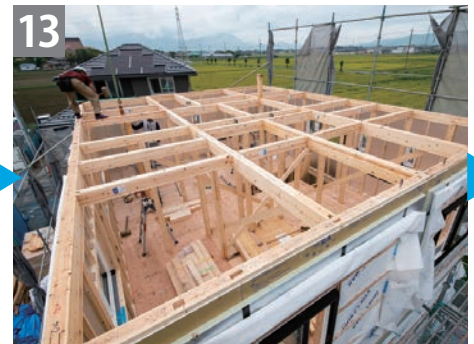
2階壁面および柱・梁施工完了
