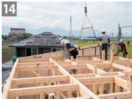
妻壁パネルの施工
