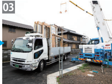
専用ラックによる大型パネル搬入
